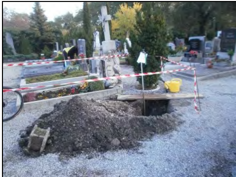
Grabarbeiten zur Brunnenerrichtung begonnen
