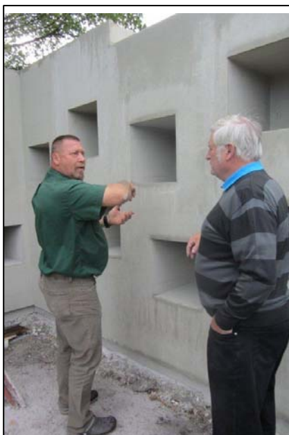
Baufortschritt der Urnenwand
